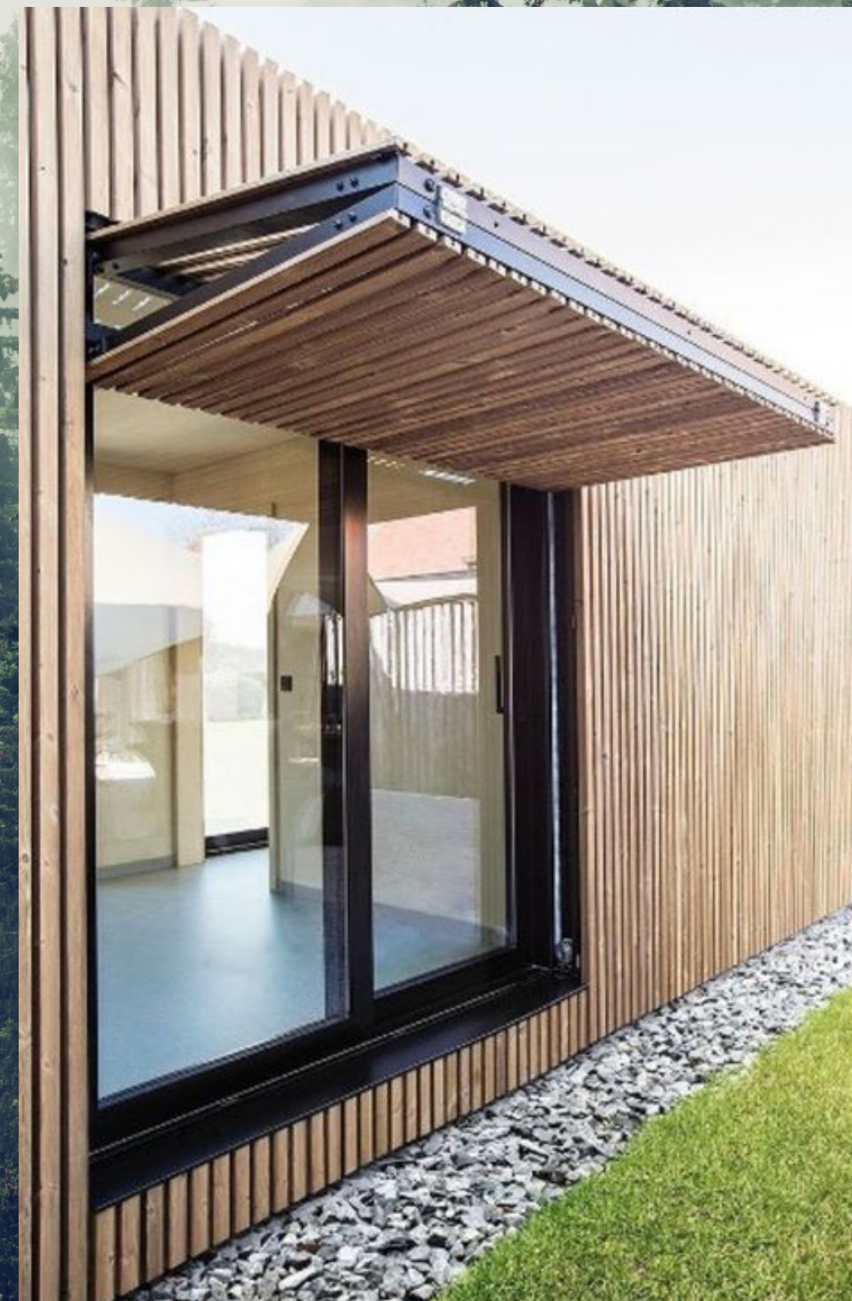
Ylöspäin nouseva mekaaninen taiteovi luo katoksen kulkuaukkoon. Tämä ratkaisu on oiva valinta myös kausisäilytykseen.
